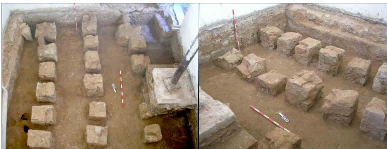
Vista general dels basaments o pilars documentats a l'interior de la sagristia
