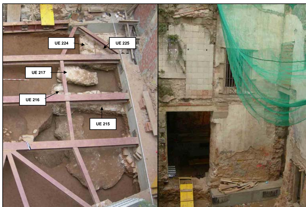
Vista general de les estructures relacionades amb l'escala del pati i de l'indret on s'ubicava
