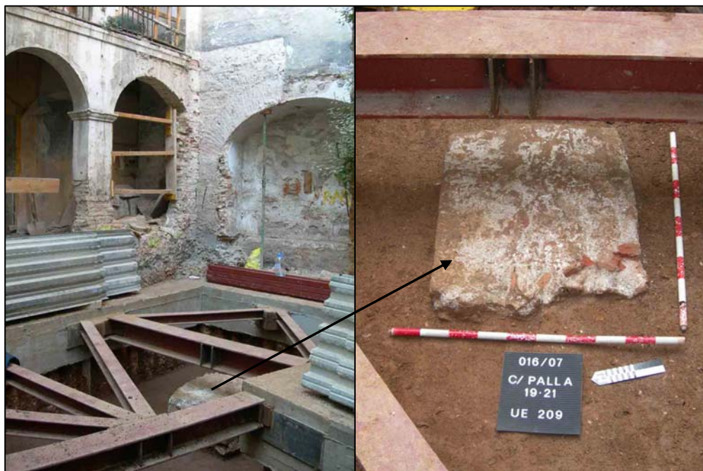
Vista general del pòrtic nord del claustre (no conservat) i detall del basament ue 209
